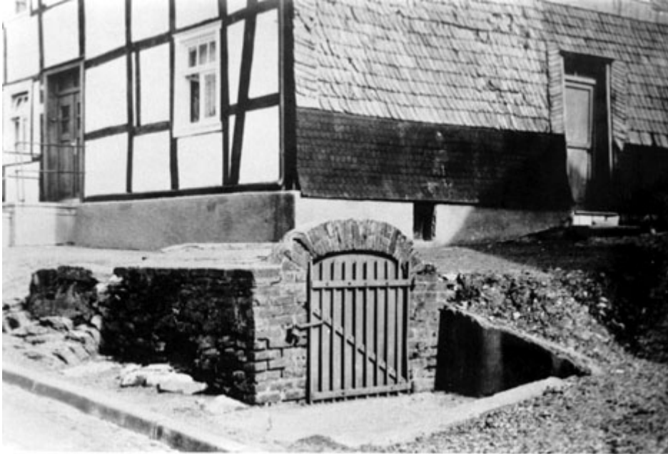
Bild: Belecker Feuerlöschteich in der Altstadt 1955
